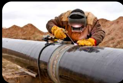
WELDING - MIG & MAG
